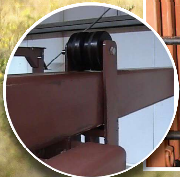
Hydraulic slide door rollers
